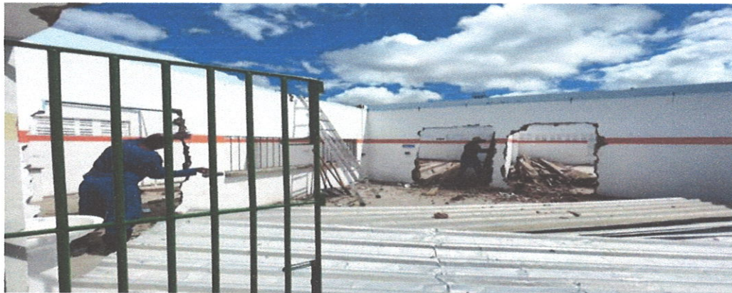
TAPUME COM TELHA METÁLICA
