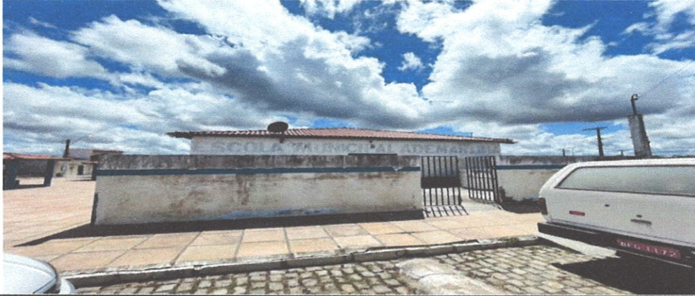
INSTALAÇÃO DE PLACA DE OBRA
