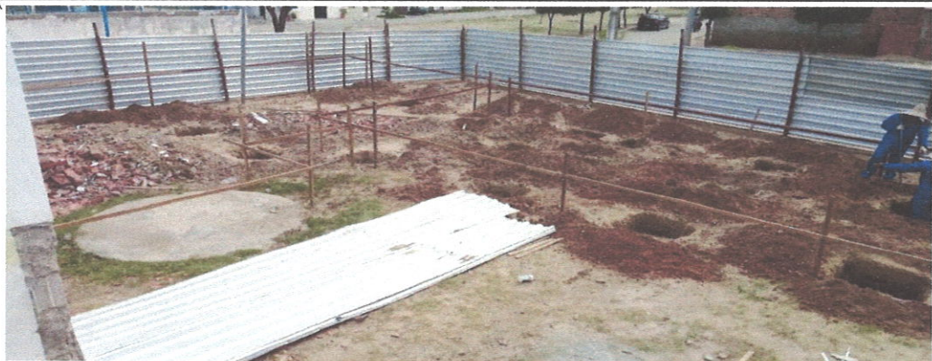
ESCAVAÇÃO MANUAL DE SAPATAS
