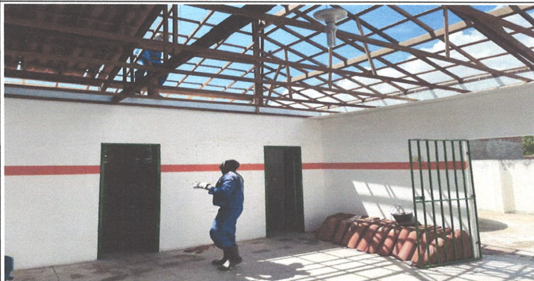
REMOÇÃO DE TELHAS CERÂMICA
