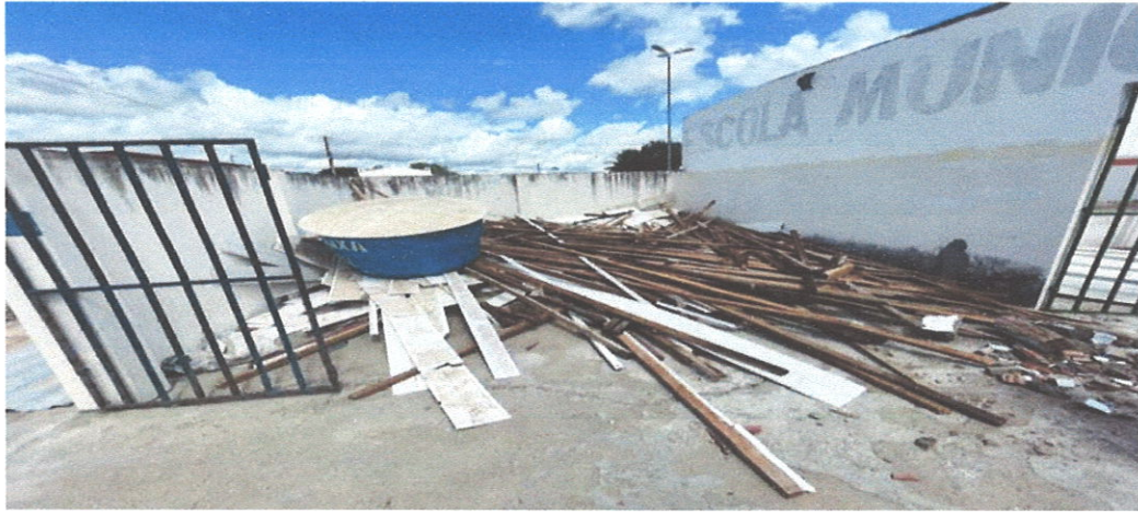
DEMOLIÇÃO DE ALVENARIA DE BLOCO CERÂMICO
